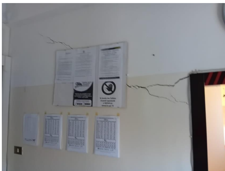
Locale del sub 8
